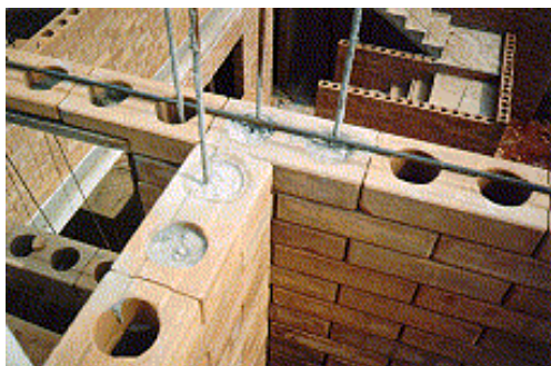
Figura 1 – Amarração em encontro de paredes e detalhe do tijolo furado. Fonte: http://www.bsi.com.br/unilivre/centro/experiencias/experiencias/395.html
