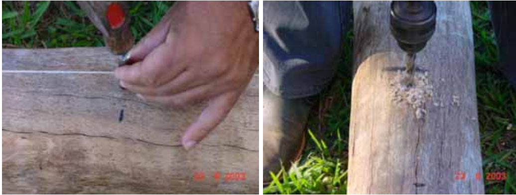
Figura 4 – Marcação e pré-furação para colocação dos pinos
