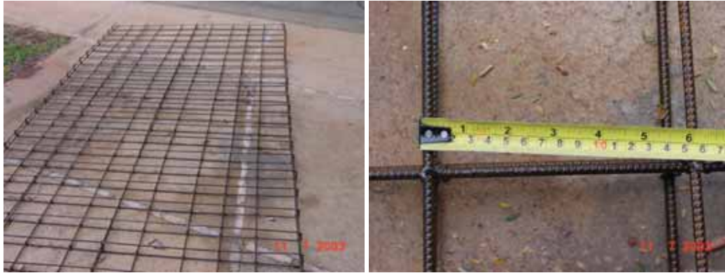
Figura 7 – Armadura da laje de concreto e verificação da distância entre as armaduras
