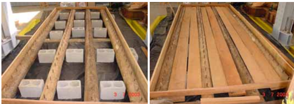
Figura 8 – Montagem da forma de concretagem
