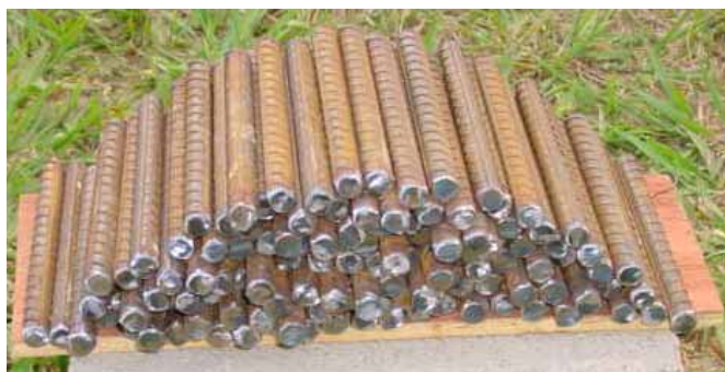
Figura 3 – Pinos utilizados na construção da ponte
