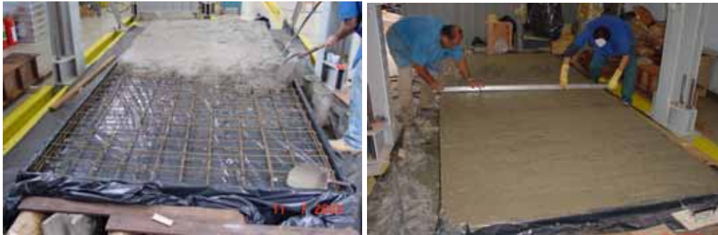
Figura 10 – Concretagem e acabamento na superfície da laje de concreto armado
