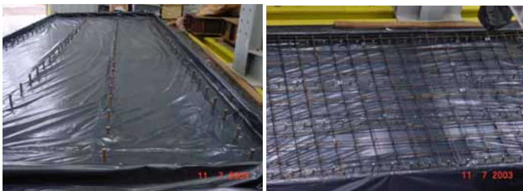
Figura 9 – Preparação da forma para concretagem
