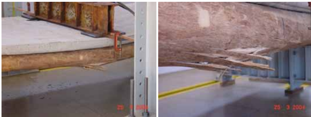
Figura 17 – Ruptura das vigas de madeira com carregamento distribuído
